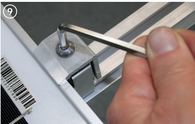
9 Ist das Modul an der gewollten Stelle, alle vier Klemmen im Wechsel fest anziehen.
