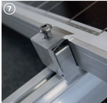
7 Schraube E einsetzen und locker anziehen.
